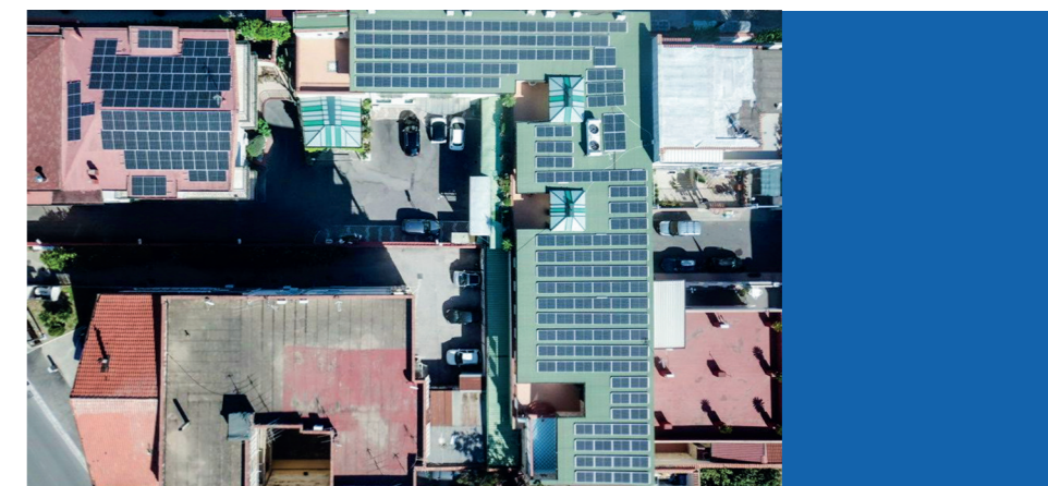
Impianto Fotovoltaico - Torino Commercio Srl Cardito (NA) - Potenza 100kWp
