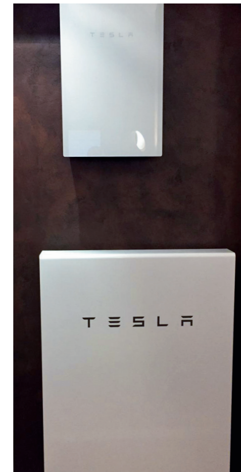
Accumulo di Energia Residenziale - TESLA Power Wall II - Capacità di Stoccaggio Energia 13,5 kWh
